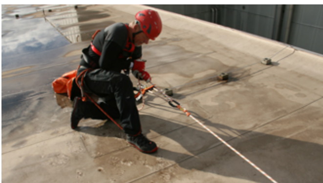
Abb. 10: Temporäres Seilsystem (Life-Line) mit Karabinerhaken an EAP befestigt
