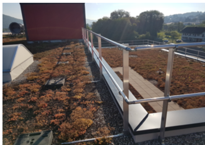
Abb. 23 Ausstattungsstufe 3: Seitenschutzsystem mit Auflast
