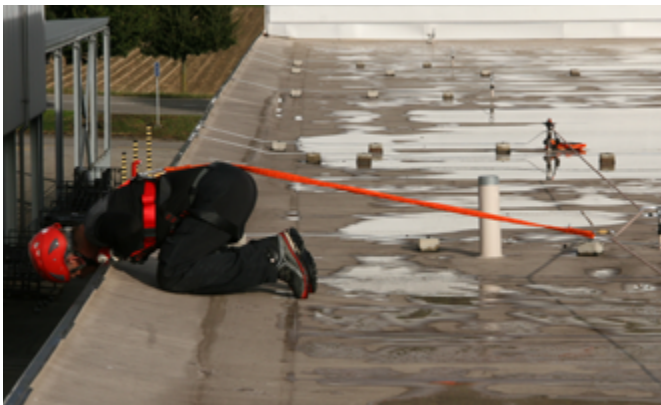
Abb. 9: Arbeiten mit Rückhaltesystem an temporärem Seilsystem
