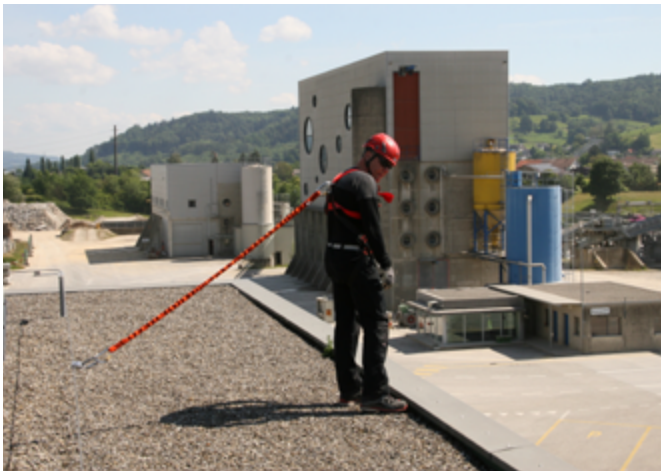
Abb. 1: Rückhaltesystem durch Verbindungsmittel mit fixer Länge zu Anschlagereinrichtung
