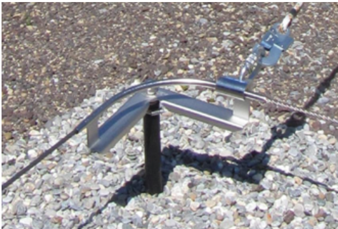
Abb. 17: Frei überfahrbarer Eckpunkt gemäss Herstellerangabe
