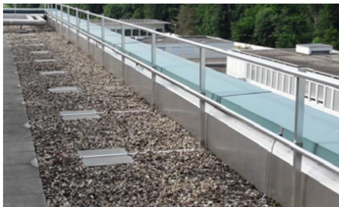
Abb. 24 Ausstattungsstufe 3: Seitenschutzsystem mit Auflast bodenebenen montiert
