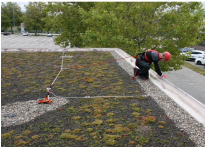
Abb. 3: Mitlaufendes Auffanggerät an beweglicher Führung als Verbindungsmittel zur Anschlagereinrichtung, manuell eingestellt, das einen Absturz verhindert
