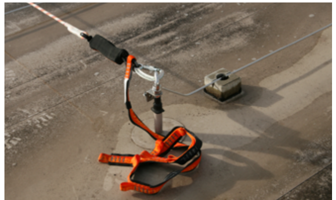
Abb. 12: In temporärem Seilsystem (Life-Line) eingebauter Falldämpfer zur Begrenzung der Kräfte auf die Anschlagpunkte
