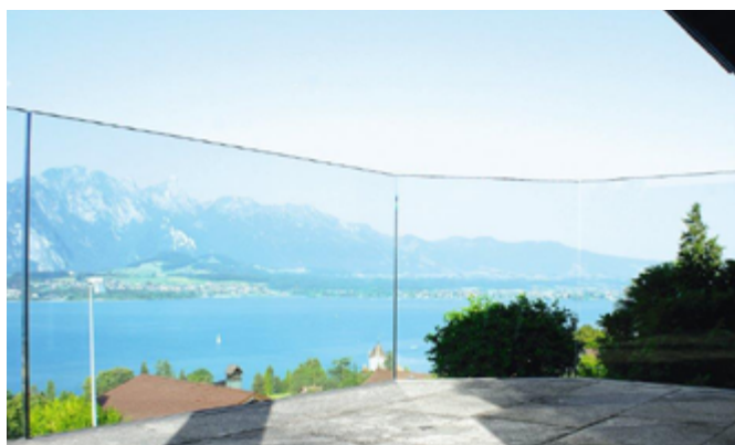
Abb. 26: Ausstattungsstufe 4 für Dachflächen, die öffentlich zugänglich sind
